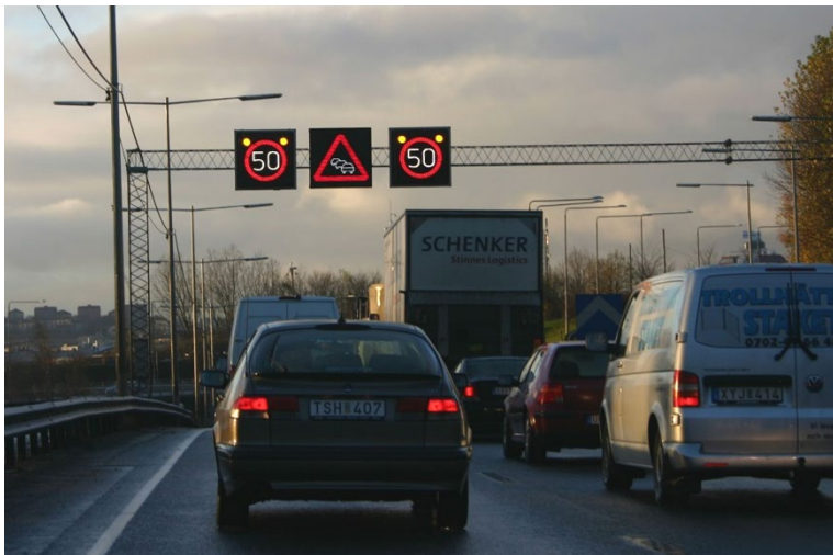
Kövarningssystemet på E6 norr om Göteborg är ett av de system som är anslutna till den nationella plattformen.
